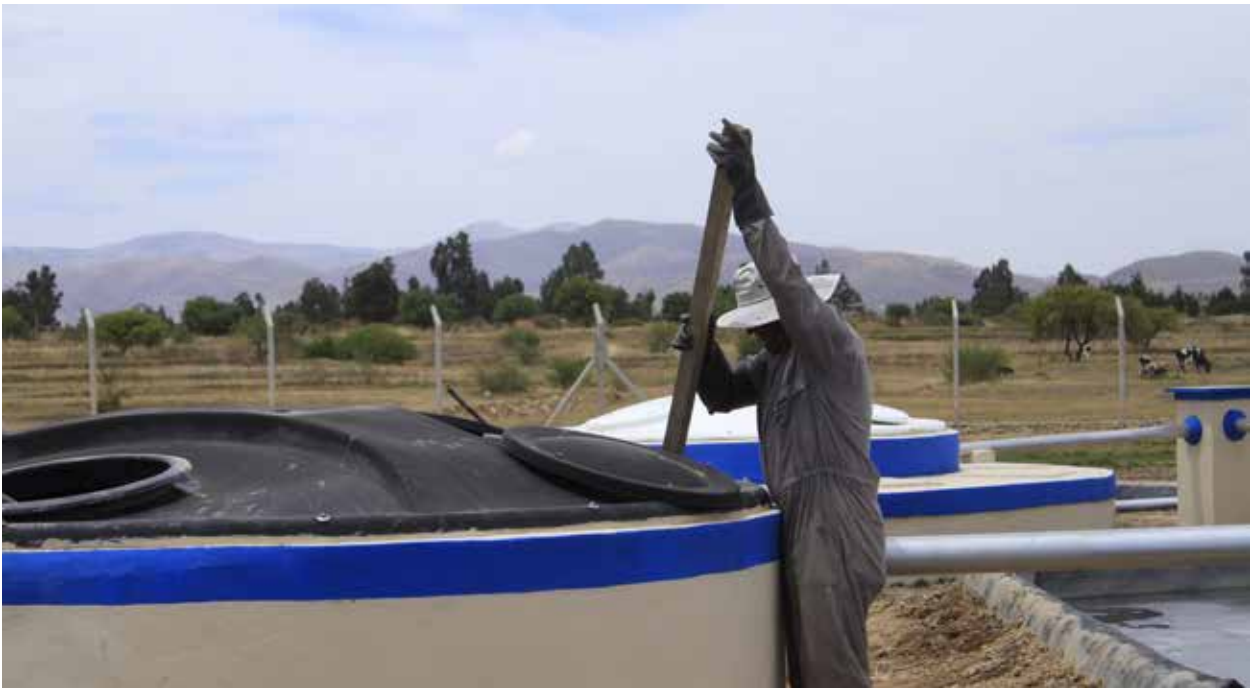
Mantenimiento de la PTAR en Cliza.
